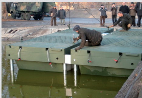
Łączenie modułów (widok od strony nurtu)
