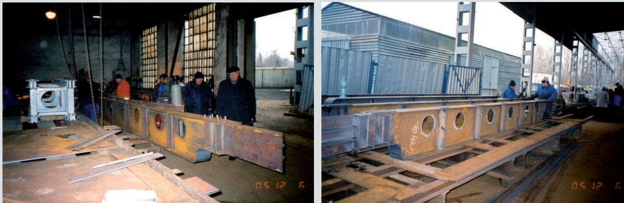
Produkcja zmodernizowanej belki poprzecznej
