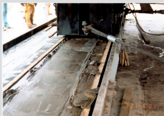
Przygotowanie toru wodowaniowego
