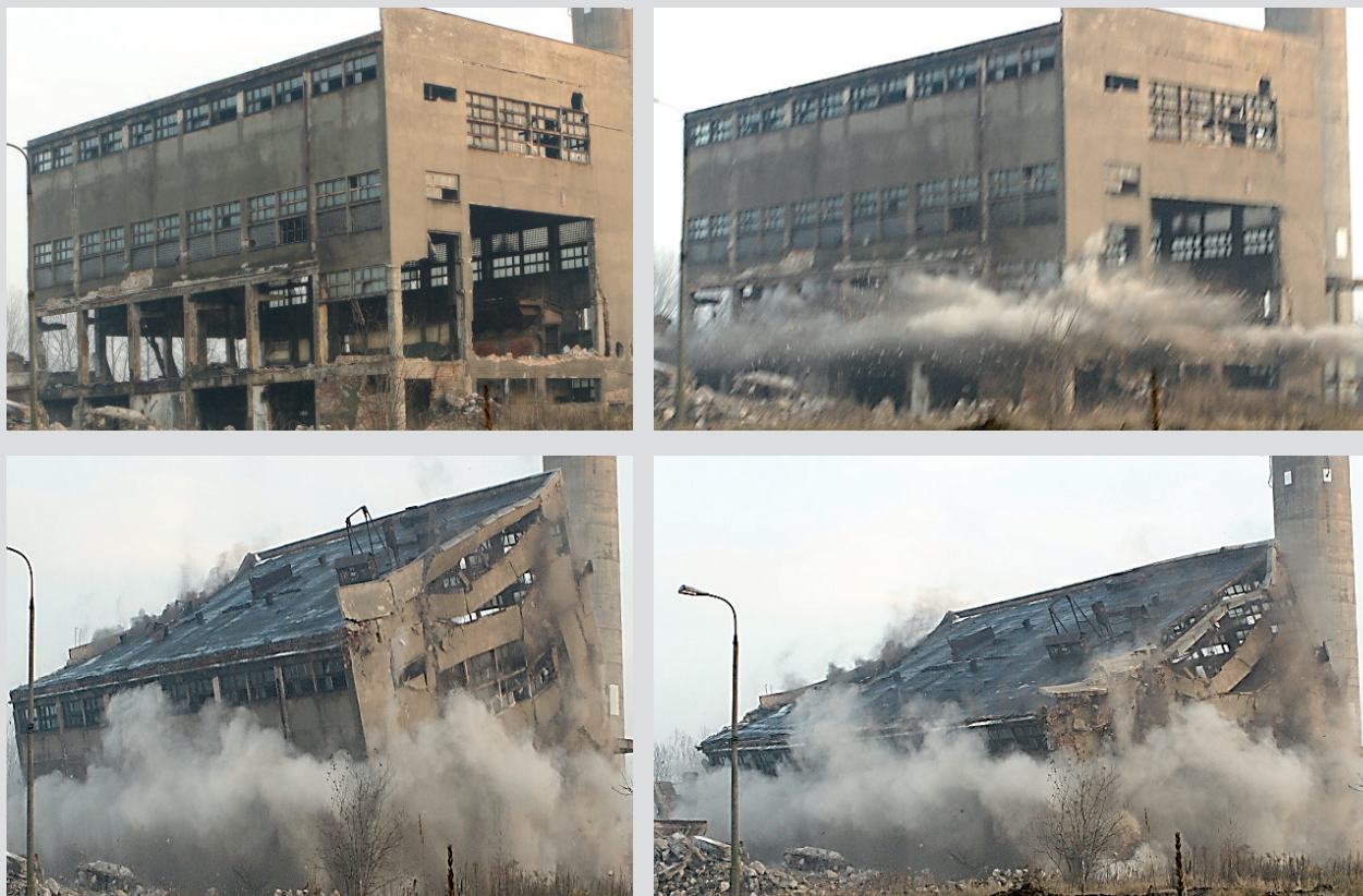
Rozbiórka budynku kotłowni w Łomży. Poszczególne fazy destrukcji obiektu
